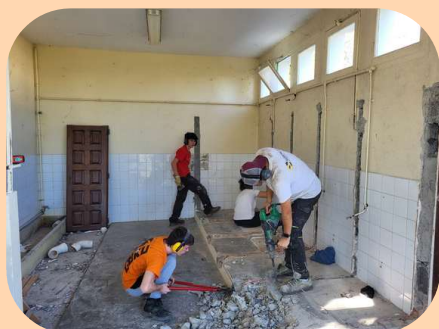
Rénovation des toilettes du préau
